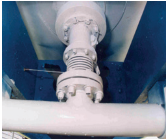
Figura 8. VVS y amortiguador antivibratorio
