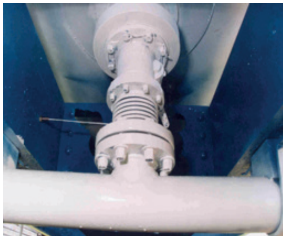
Figura 8. VVS y amortiguador antivibratorio
