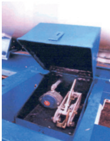
Figura 4. Caja de seguridad para protección de manija de accionamiento
